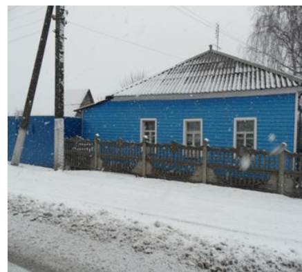
Фото 3. Здание бывшего маслозавода
